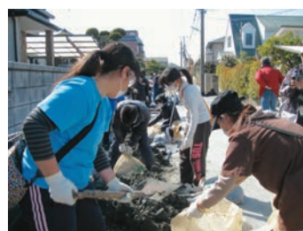
U字溝 土砂撤去
